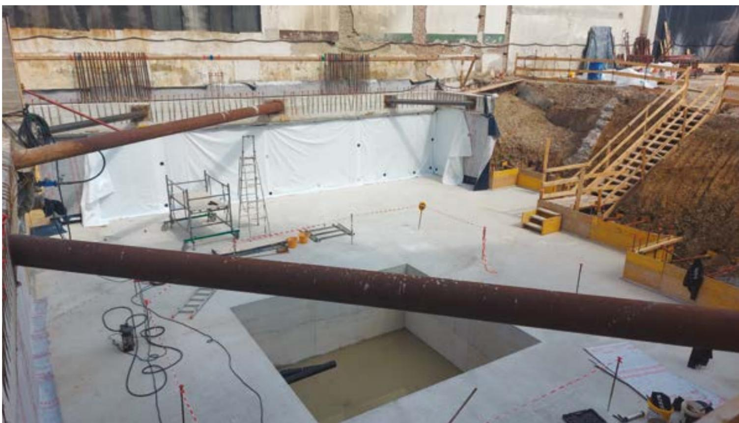
la posa delle membrane, con verifica costante della qualità e della tenuta.
