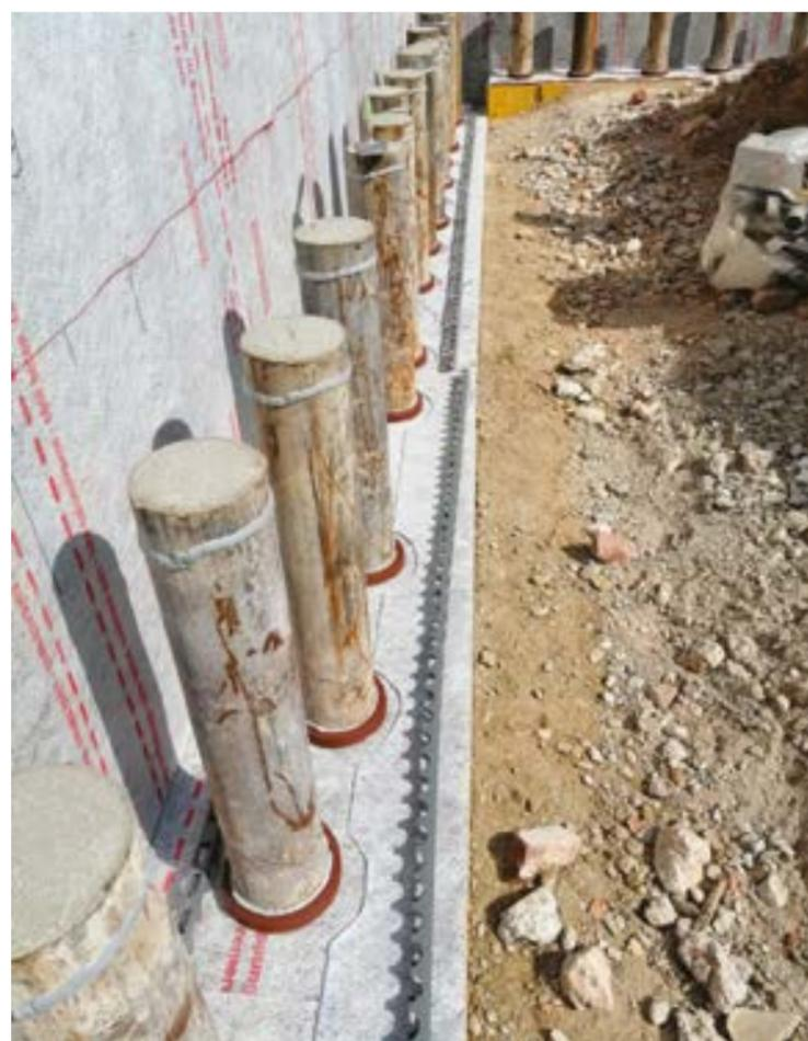
dell'attraversamento dei micropali della berlinese. In questo modo si è potuto generare il collegamento con le impermeabilizzazioni di copertura sul perimetro esterno evitando interferenze con la struttura.
