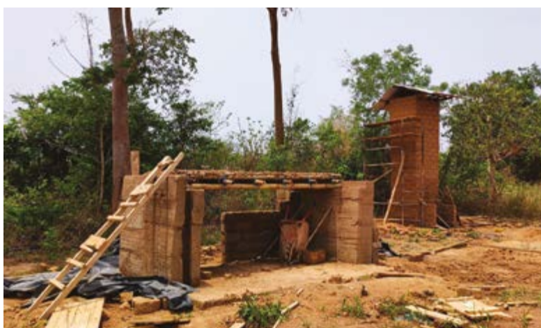
Piccolo cantiere avviato in Costa d'Avorio con la collaborazione dei giovani costruttori locali; sulla sinistra il prototipo in bambù e terra cruda e sulla destra il forno per trattare il bambù
