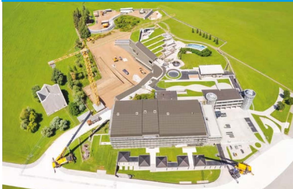
Figura 1. Vista generale dell'area di cantiere
