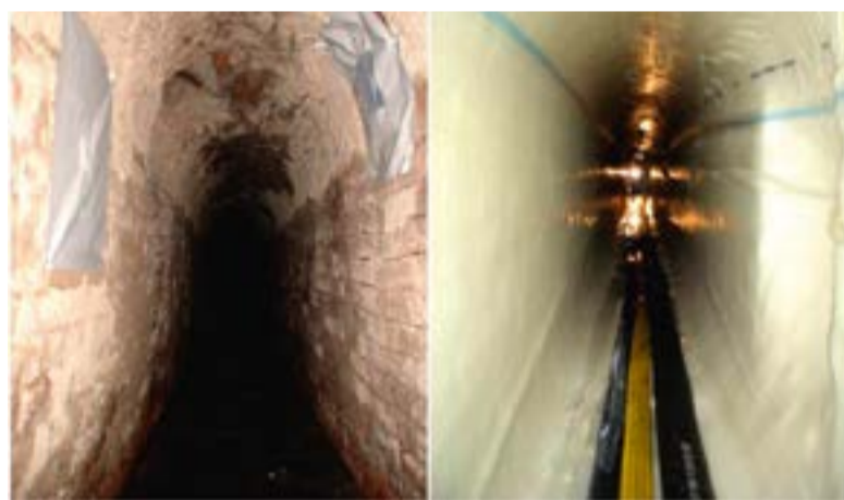
Foto 2. Intervento con tecnica Cured in Place Pipe prima e dopo l'intervento
