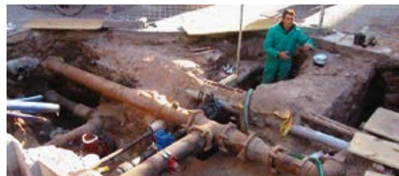
Foto 3 e 4. Intervento con tecnica hose lining su condotta acquedotto all'interno dell'impalcato del Ponte Coperto di Pavia
