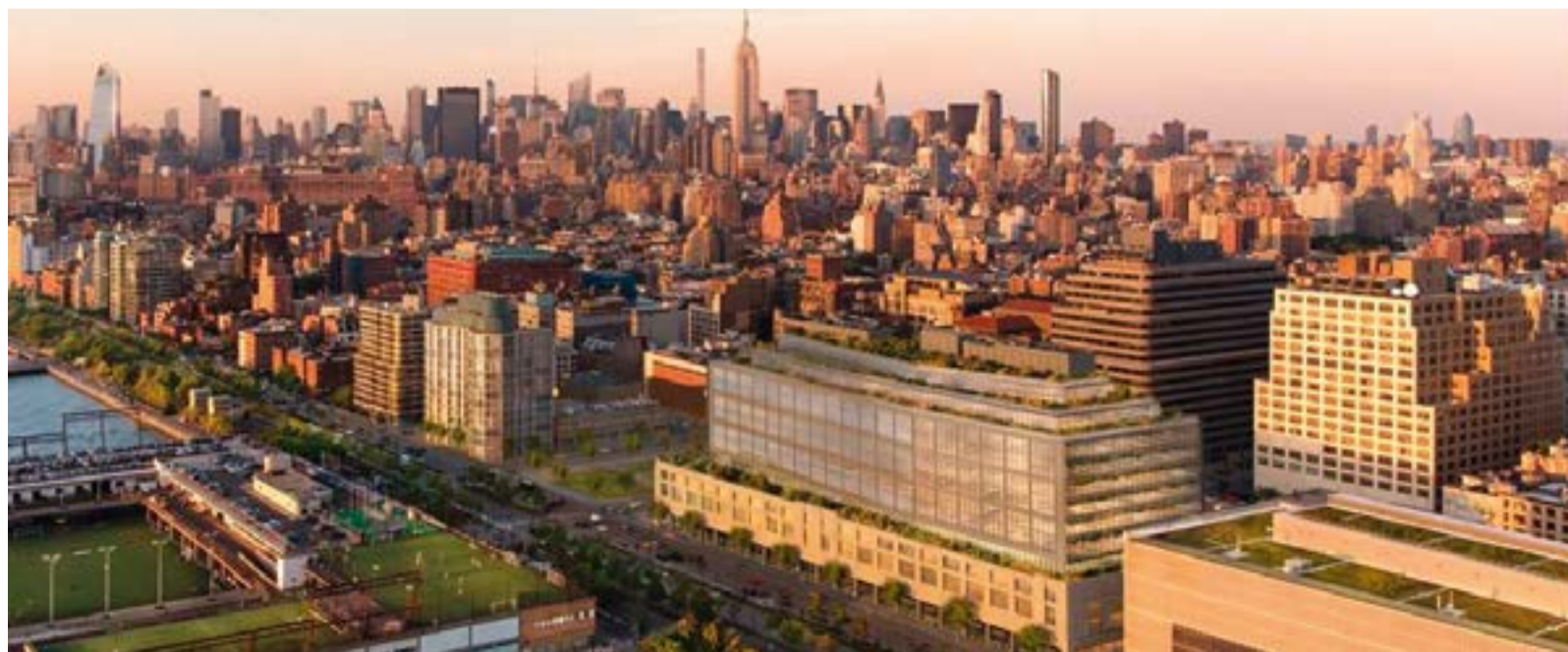
Figura 1. Vista del nuovo edificio nel contesto
