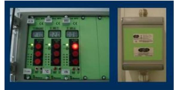
Indicazione che i tempi di risposta del sistema di rilevazione dell'ossigeno siano tali da garantire che alla soglia del 18%O<sub>2</sub> la ventilazione di emergenza si attivi entro **20 secondi** (**raccomandazioni INAIL, 6/7 secondi per nuove installazioni**).
